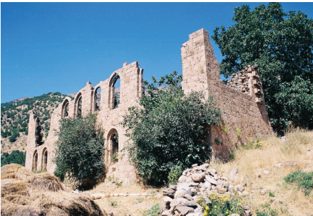
Fotoğraf: 7 Şemdinli Kayme Konağı Kuzeybatı Görünüşü
